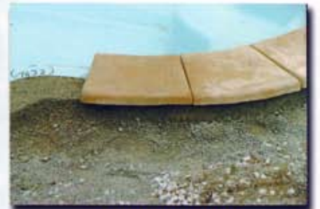
POSE DES MARGELLES
